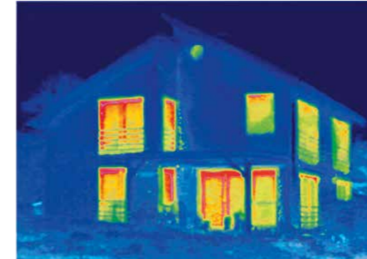
Infraroodopnamen, thermografieën, laten duidelijk zien waar er warmte-energie ontsnapt uit het huis. Rood staat voor warmte en bijgevolg een hoog energieverlies.
